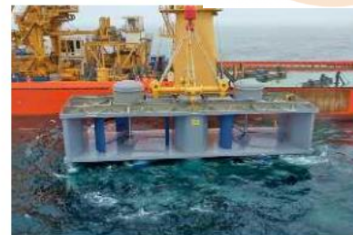
Mise à l'eau de l'hydrolienne
