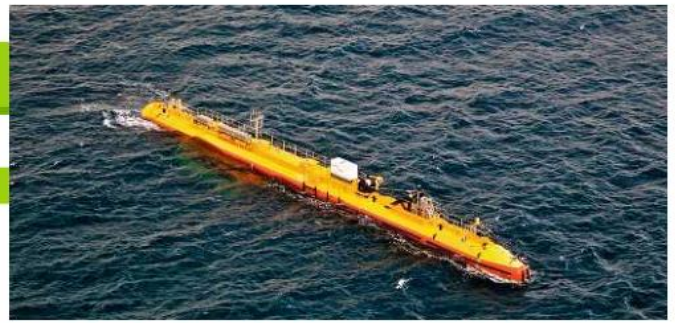
En 2016, une hydrolienne flottante a été installée en mer au large des îles Orcades, en Écosse, pour produire de l'énergie électrique à destination de ces îles.
