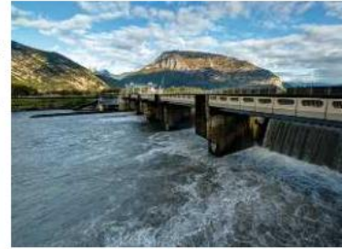
Une centrale hydroélectrique
