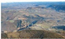
5. Le viaduc de Millau
