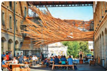
Une caserne du XIX e siècle en cours de réhabilitation (Bordeaux)
